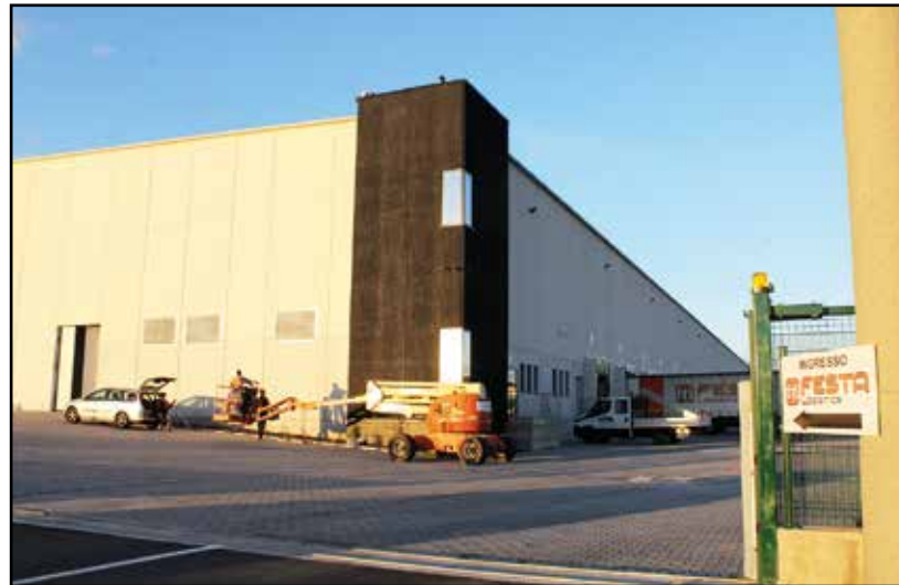
Il nuovo capannone a fianco della Lombarda Prefabbricati.
