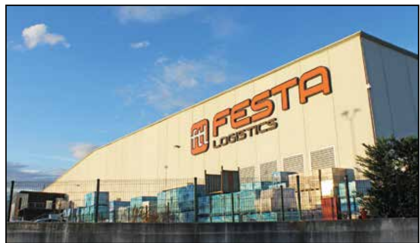
L'insegna della ditta Festa Logistics all'ingresso del complesso industriale. (Foto Mor)
